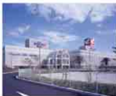
ALC外壁施工の店舗
