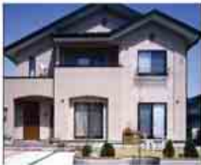
ALC外壁施工の住宅
