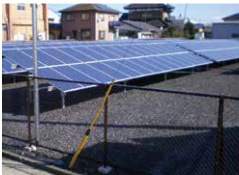
太陽光パネル防草敷均し材
