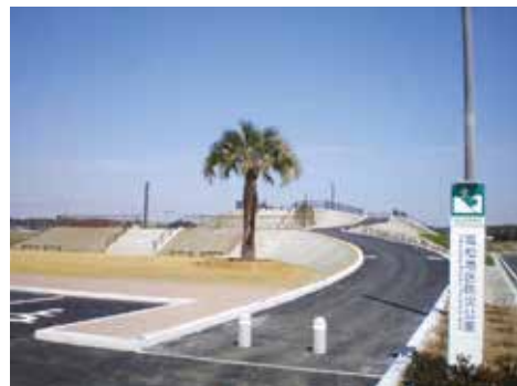
防災公園盛土材
