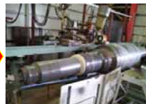
溶接復元(軸部)
