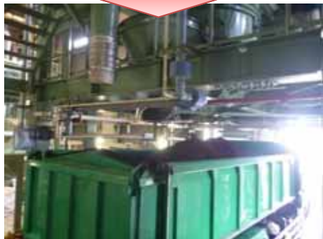
図 焼却灰トラック輸送
