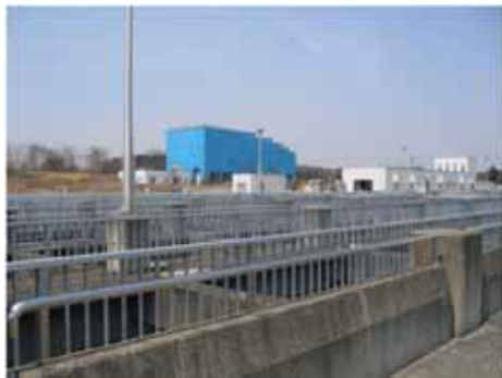
図 下水処理場
