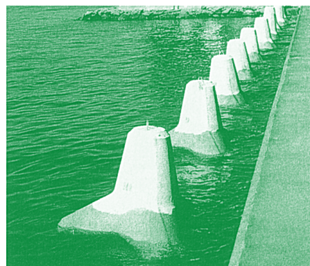
スラグ利用消波ブロックの敷設状況
