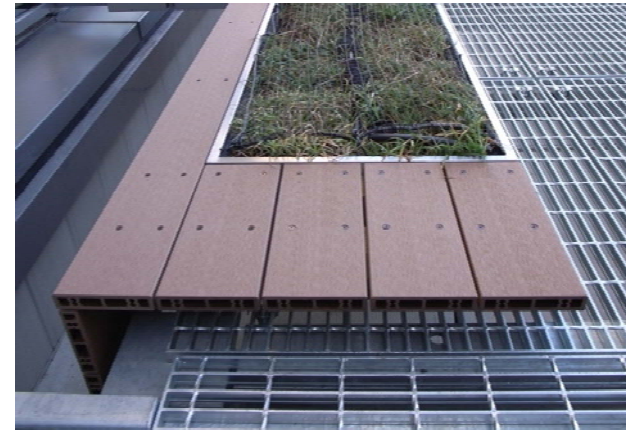
デッキ材として新ビルへ施工
