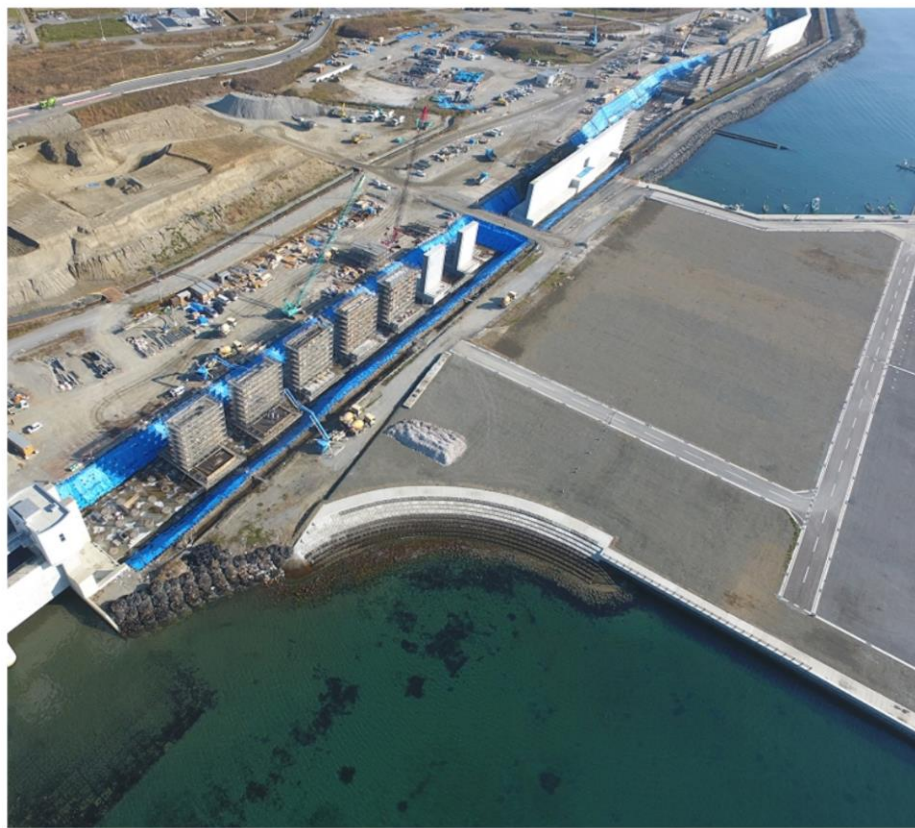
岩手県陸前高田市 災害復旧事業 防潮堤建設中
