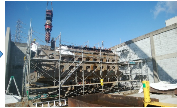
切替スイッチ(変圧器内部部材)取り外し
