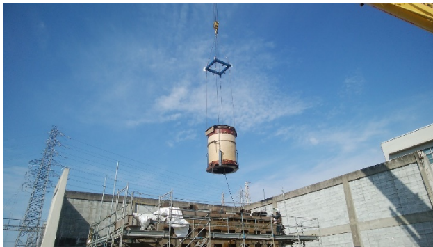
コア(変圧器内部部材)吊り上げ
