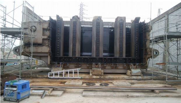
鉄心(変圧器内部部材) 抜取り開始
