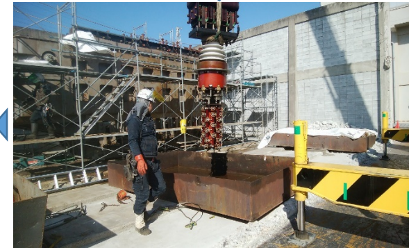
切替スイッチ(変圧器内部部材)取り外し
