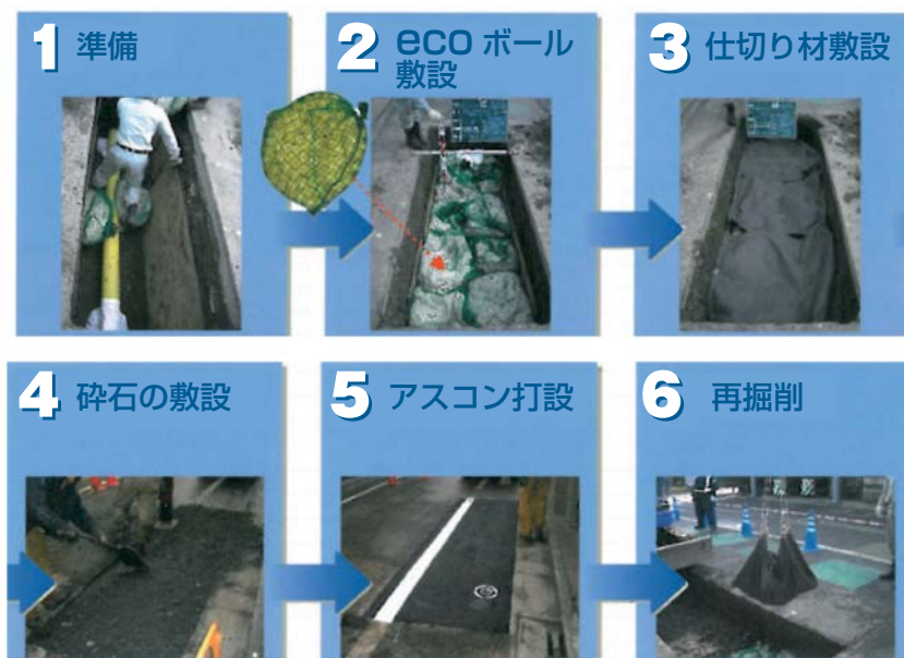
写真2 「eco ボール」を用いた施工作業の例
