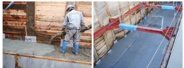
打設状況と仕上り状況（建築工事）
