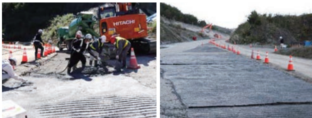
打設状況と仕上り状況（土木工事）
