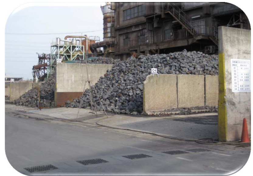
熔融還元石保管状況
