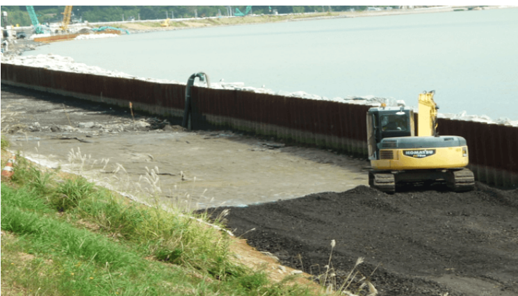
東北復興 北上川護岸工事
