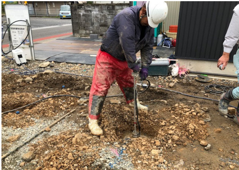
地盤補強材 注水作業
