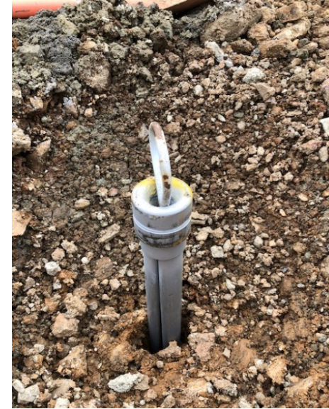
地盤補強材圧入後（拡張前）
