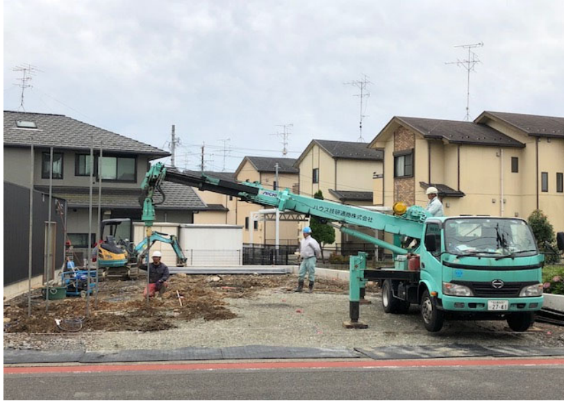
地盤補強材 圧入全景
