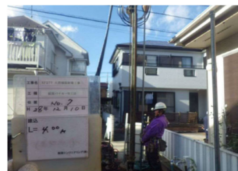
6.補強材立込み
