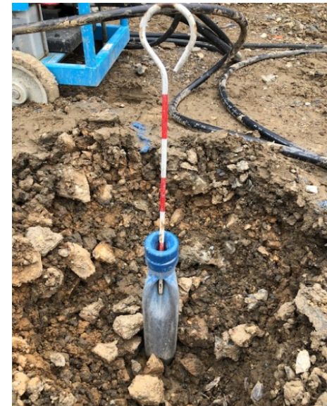
地盤補強材注水後（拡張後）
