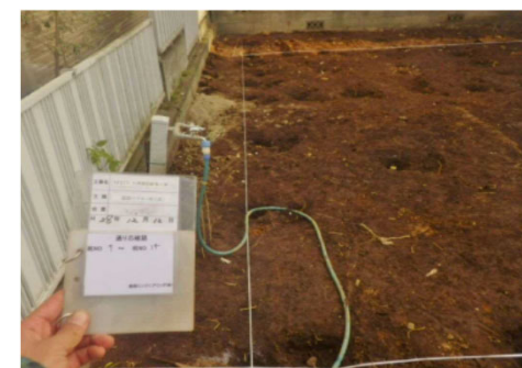
10.芯ズレ・杭レベル確認
