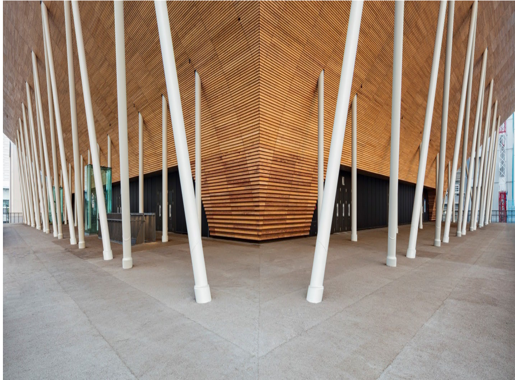
東京都 国際スポーツ施設
