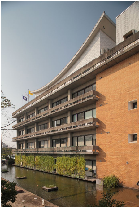
羽島市庁舎 竣工：1959年 解体：2025年
