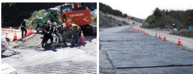
打設状況と仕上り状況（土木工事）
