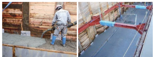
打設状況と仕上り状況（建築工事）
